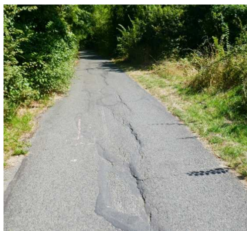
Fissures et affaissements au centre de la voie avant d'entrer dans le parc de la Poudrerie.
