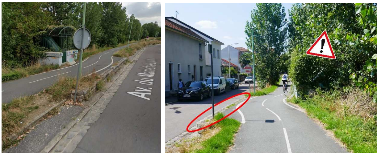
Fissures et affaissements au centre de la voie avant d'entrer dans le parc de la Poudrerie.
